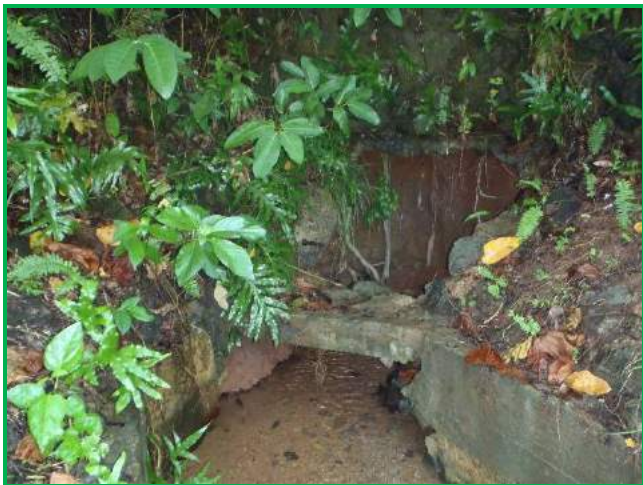
Photo 6 : « source » aménagée (bétonnée)
