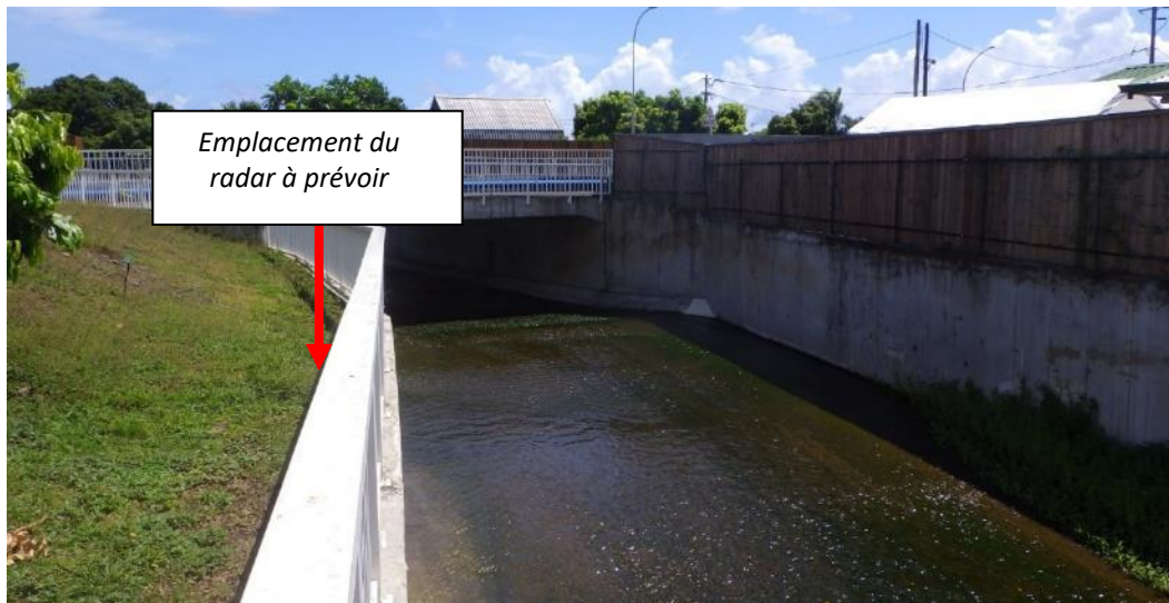
FIGURE 2 : PONT DE L'AVENUE POMARE QUI VIENT D'ÊTRE REFAIT. LA SECTION BETONNEE EST PARFAITEMENT GEOMETRIQUE.
