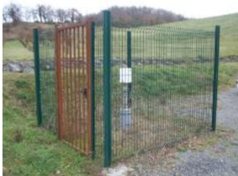
Figure 9 : Abri grillagé anti-vandalisme
