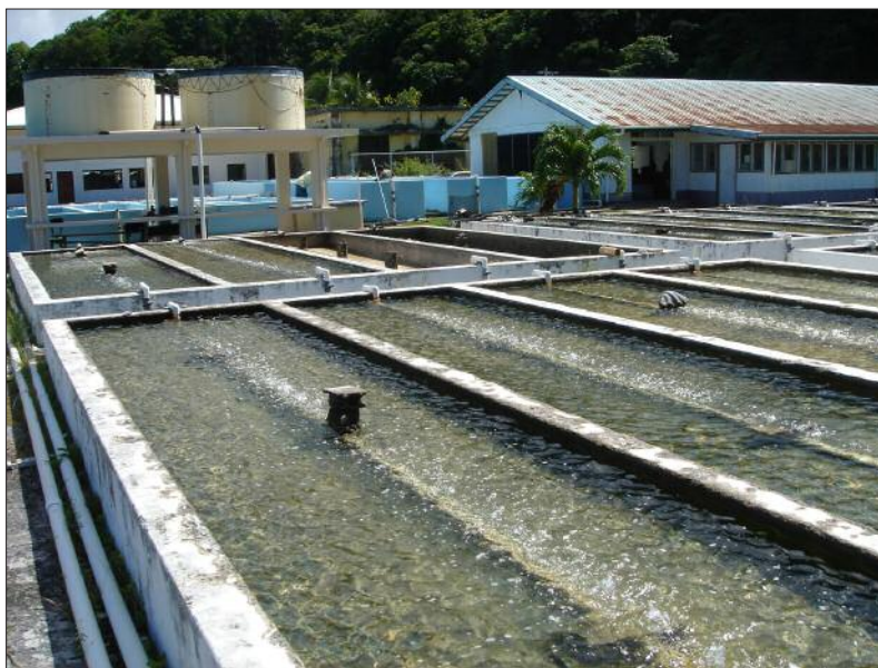
Centre de démonstration de la mariculture de Palau
