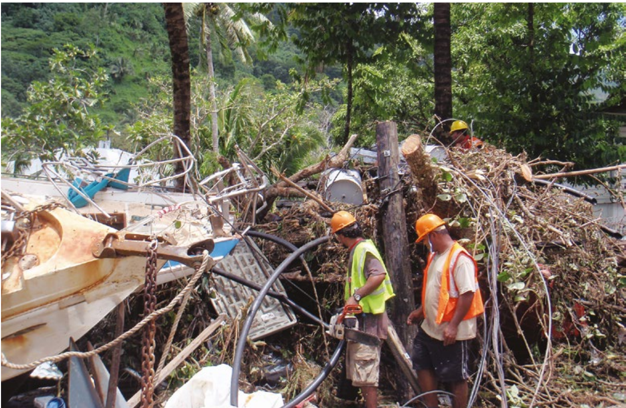
Le 29 septembre 2009, le tsunami a laissé derrière lui un paysage dévasté, fait de bateaux endommagés, d'arbres couchés, de câbles électriques arrachés et d'autres débris en tous genres (crédit photo : Telemal, FlickrR).
