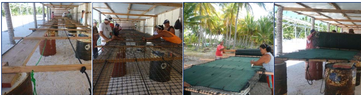
Figure 43 : (a) Pose des bois (b) Pose et fixation du grillage « netlon » (c) Pose de l'ombrière (d) Station finie et enroulée (© C. Wabnitz)
