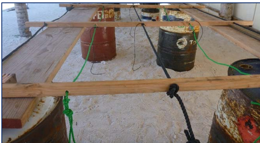
Figure 44 : Pose des cordes au travers des traverses en bois (© C. Wabnitz)
