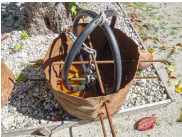
Photographie 3 : corps-mort en demi-fût – armature interne (à gauche) et unité prête à être mise à l'eau (à droite).
