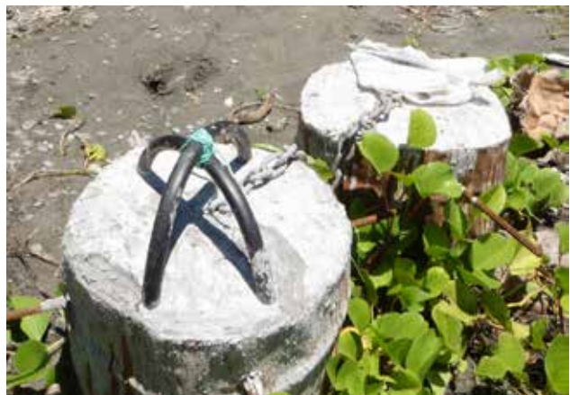
Photographie 3 : corps-mort en demi-fût – armature interne (à gauche) et unité prête à être mise à l'eau (à droite).
