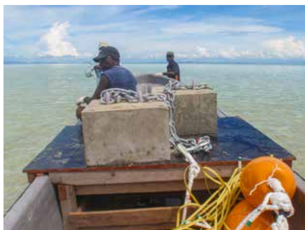
Photographie 9 : plateforme embarquée de mise à l'eau des corps-morts, avec deux configurations distinctes.
