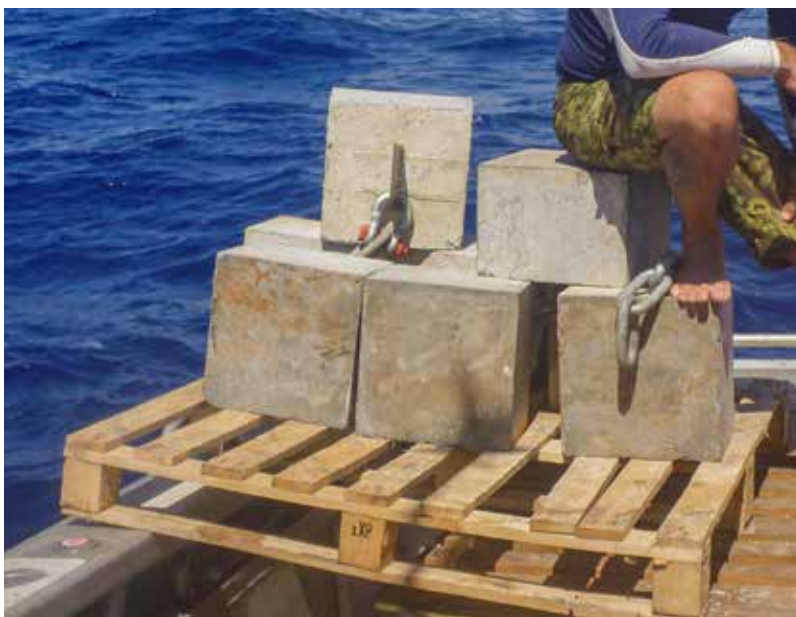
Photographie 4 : plateforme de mise à l'eau installée sur une petite embarcation, accueillant ici un ensemble de petits blocs de béton reliés les uns aux autres.
