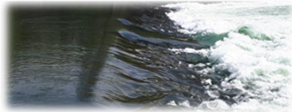
Figure 13 Seuil hydraulique : passage de fluvial-torrentiel à l'amont et torrentiel-fluvial à l'aval avec formation d'un ressaut hydraulique ; le Rhône à l'amont de Lyon ; crédit photo : Bernard Chocat.
