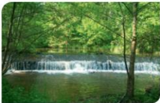
Figure 12 Seuil avec chute d'eau, source DDT Puy de Dôme 2012 (9)
