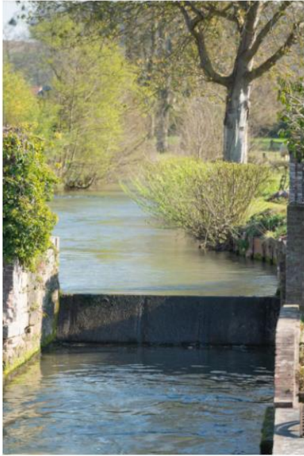
Figure 10 Seuil déversoir, source (7).
