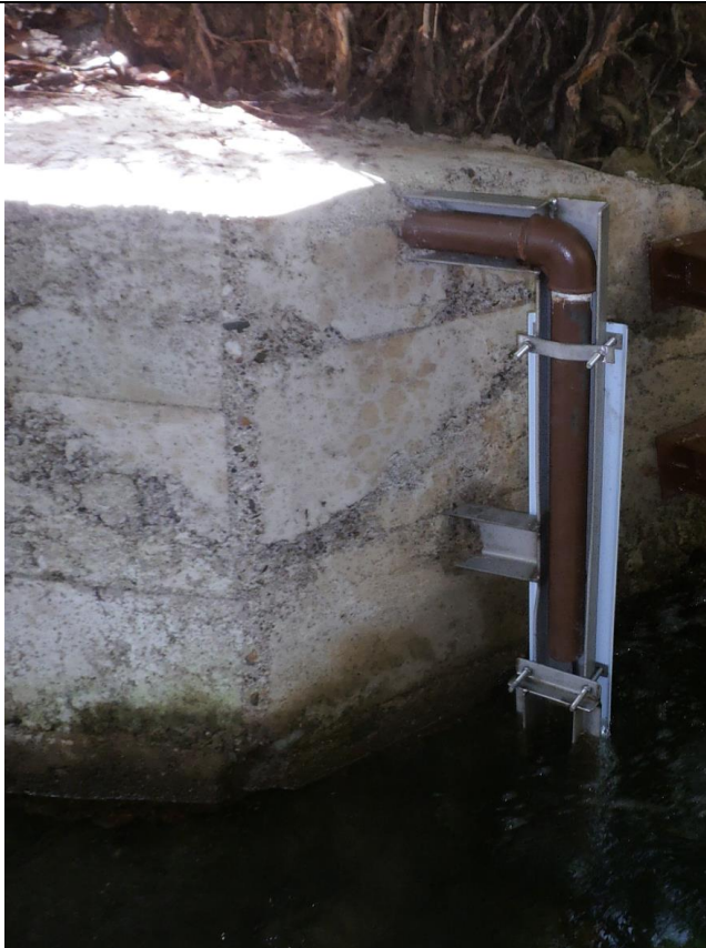
Figure 31 Exemple d'échelle implantée sur structure métallique, source DAVAR
