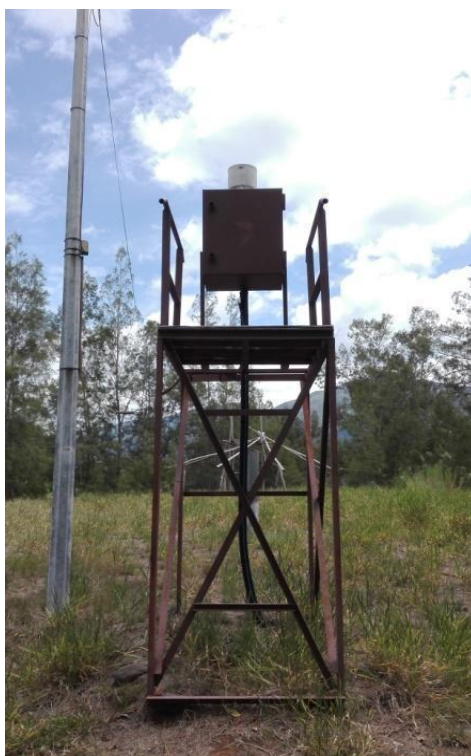
Figure 26 Guérite surélevée en zone inondable, source DAVAR
