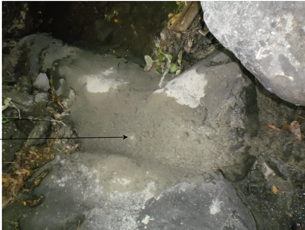
Figure 5 Repère de boulon inox pour fixer la 1ère échelle limnimétrique
