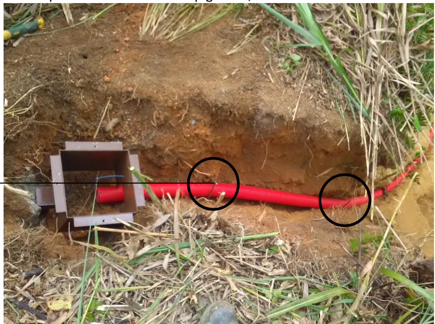
Figure 23 Installation de regard métallique, source DAVAR
