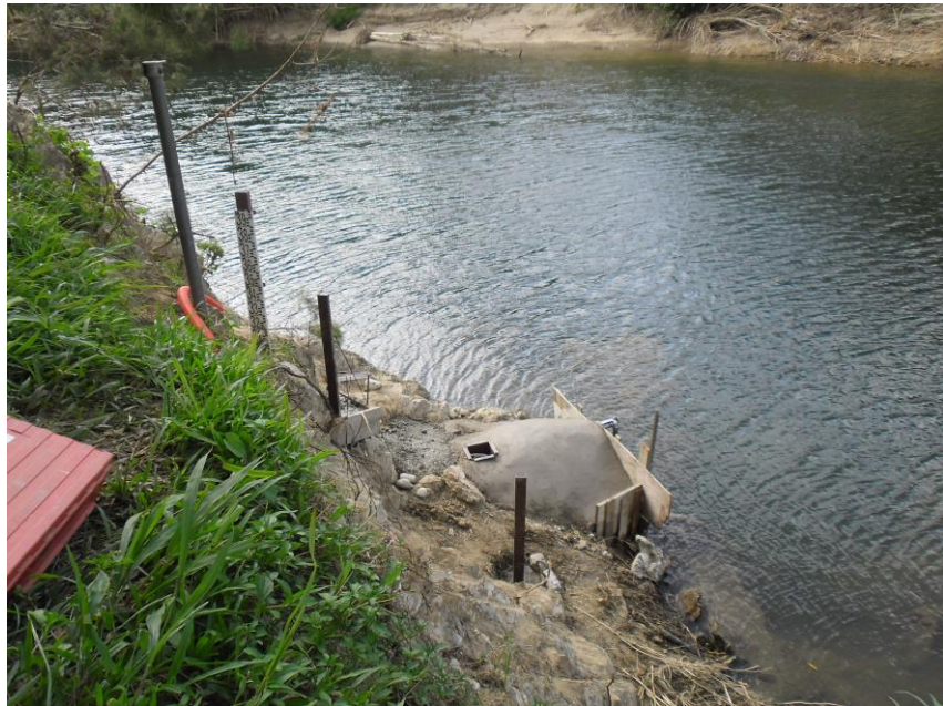
Figure 17 Coulage du béton + insertion d'un regard, source DAVAR
