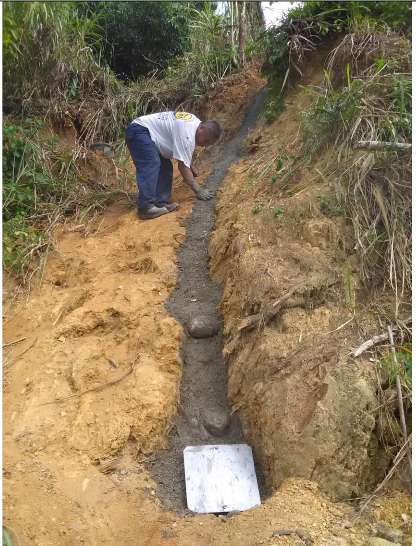
Figure 21 Tranchée bétonnée avec regard, source DAVAR
