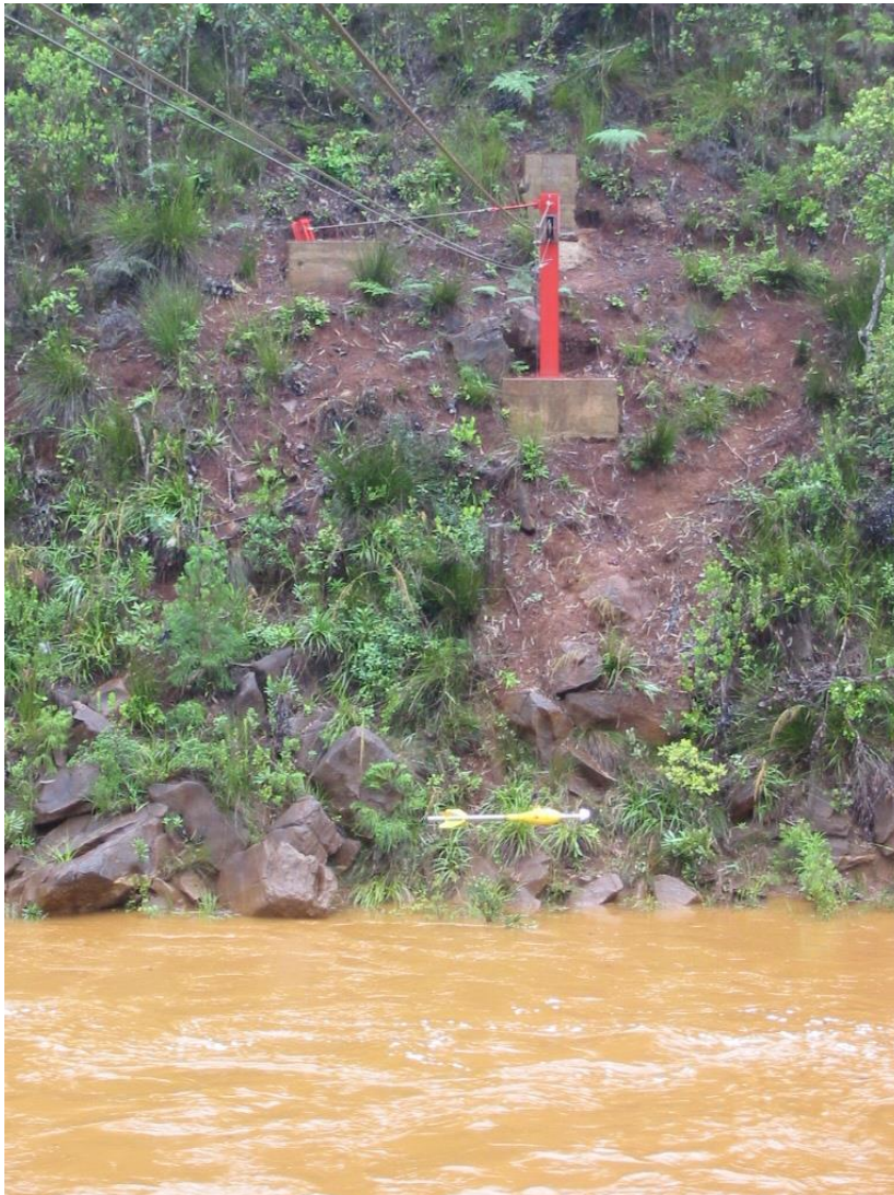
Figure 34 Station téléphérique de la Coulée, source DAVAR
