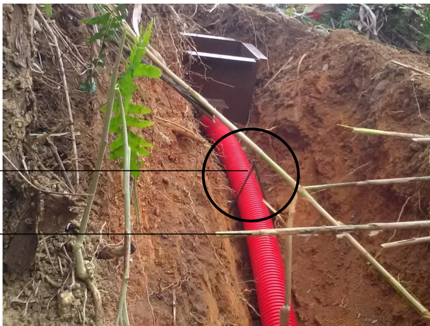
Figure 20 Tranchée avec TPC tenue par fer à béton, source DAVAR
