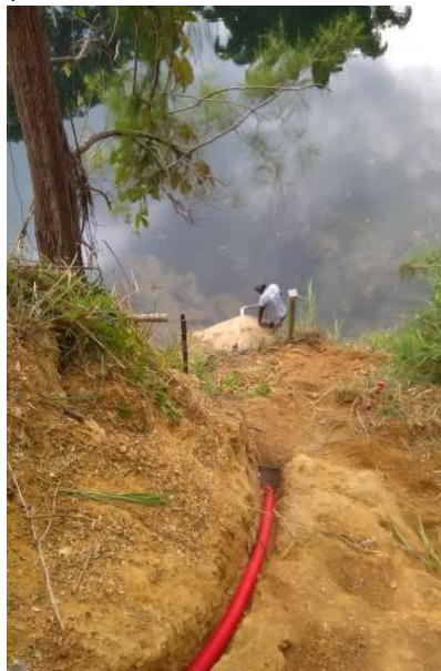
Figure 19 Tranchée avec TPC, source DAVAR
